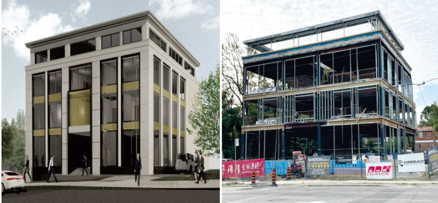
Yonge/Sheppard全新三层豪华商业办公楼在建，约12000呎+地下停车场。
