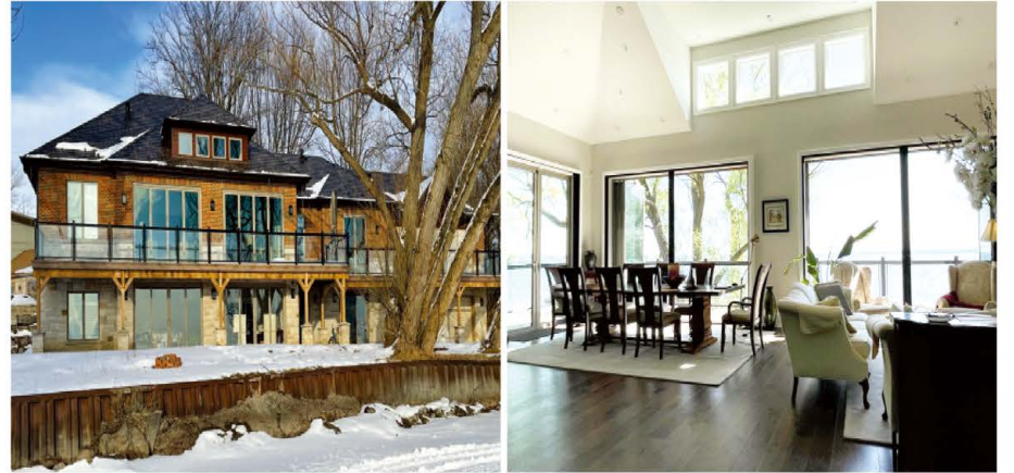
Keswick湖邊, 複式大平房完工。
