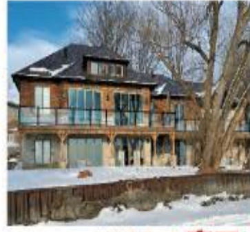
Keswick 湖边复式 完工 Keswick 湖边， 复式大平房完工。
