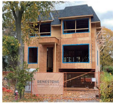
北约克豪华全独立 在建 Lawrence / Don mills, 豪华两层全独立，约 4000 呎。
