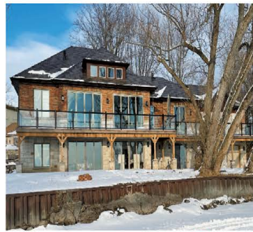
Keswick 湖边复式 完工 Keswick 湖边， 复式大平房完工。
