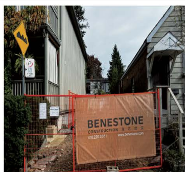
市中心豪华全独立 新开工 Dundas St E. / Coxwell Ave. 豪华两层全独立，约 1200 呎。
