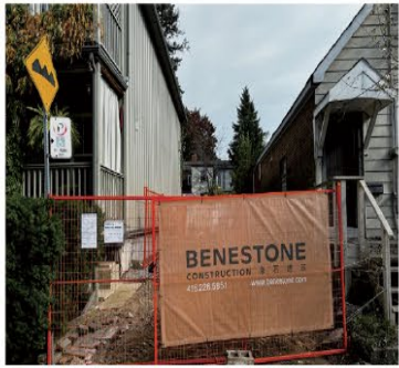
市中心豪华全独立 新开工 Dundas St E. / Coxwell Ave. 豪华两层全独立, 约 1200 呎.
