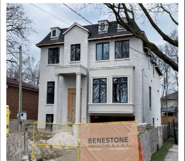
北約克豪華全獨立 在建 Lawrence Ave/Bathurst St., 豪華兩層全獨立, 約 4300 呎.
