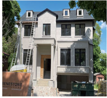
北約克豪華全獨立 在建 Lawrence Ave/Bathurst St., 豪華兩層全獨立, 約 4300 呎.
